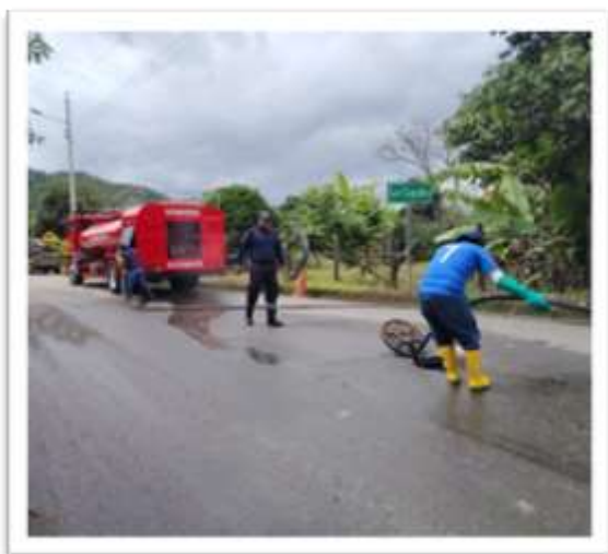
Limpieza de alcantarillado en barrio de la parroquia El Tambo
