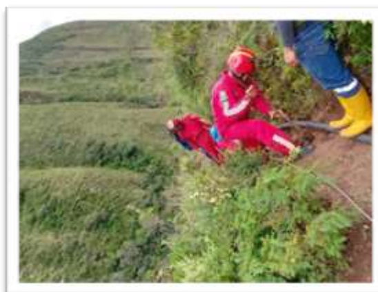
Colaboración en reparación de toma de agua en San Pedro de la Bendita
