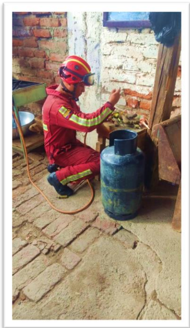
Control de fuga en cilindro de GLP.
